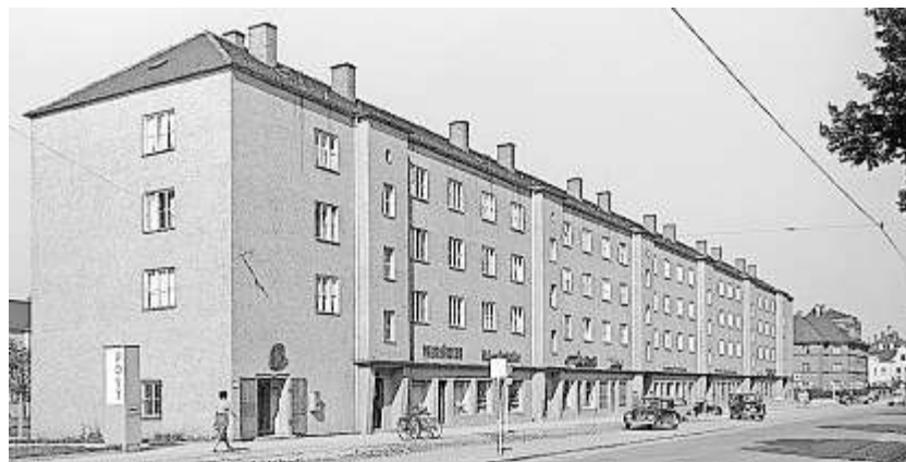
Gleich neben der Post (links) im Staudingerblock an der Landshuter Straße war die Stadtteilbücherei Ost seit 1951 untergebracht.
